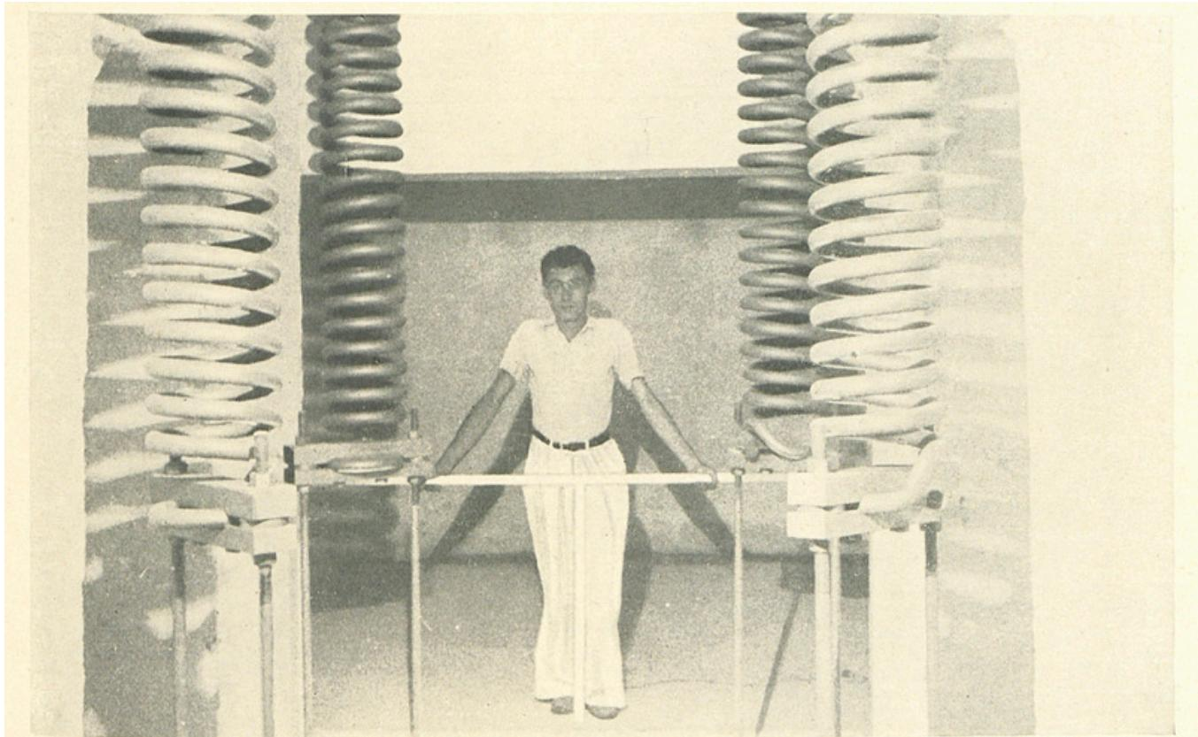
Partie supérieure du séismographe de Quervain-Piccard : ressorts de suspension de la masse de 20 tonnes.
