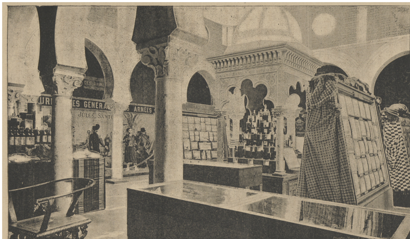
Fig. 3. — Pavillon de la Tunisie, vue intérieure. — M. Maurice Yvon, architecte (D'après une photographie)
