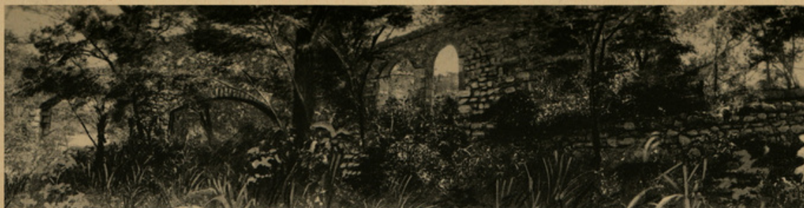
AQUEDUC DE L'HABITATION LAMARDELLE
