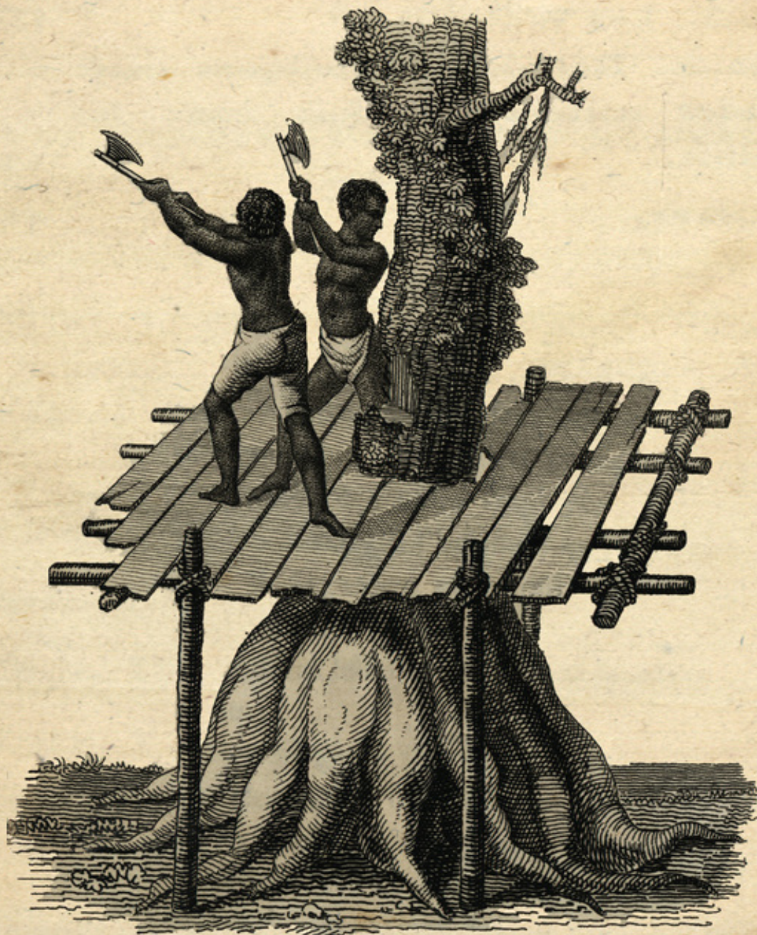
Boucan ou échaffaudage pour couper des Arbres au dessus des Racines
