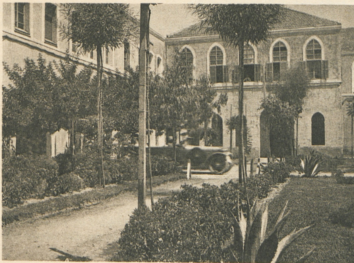
Bâtiment du Bureau topographique dans le Grand Sérail.
