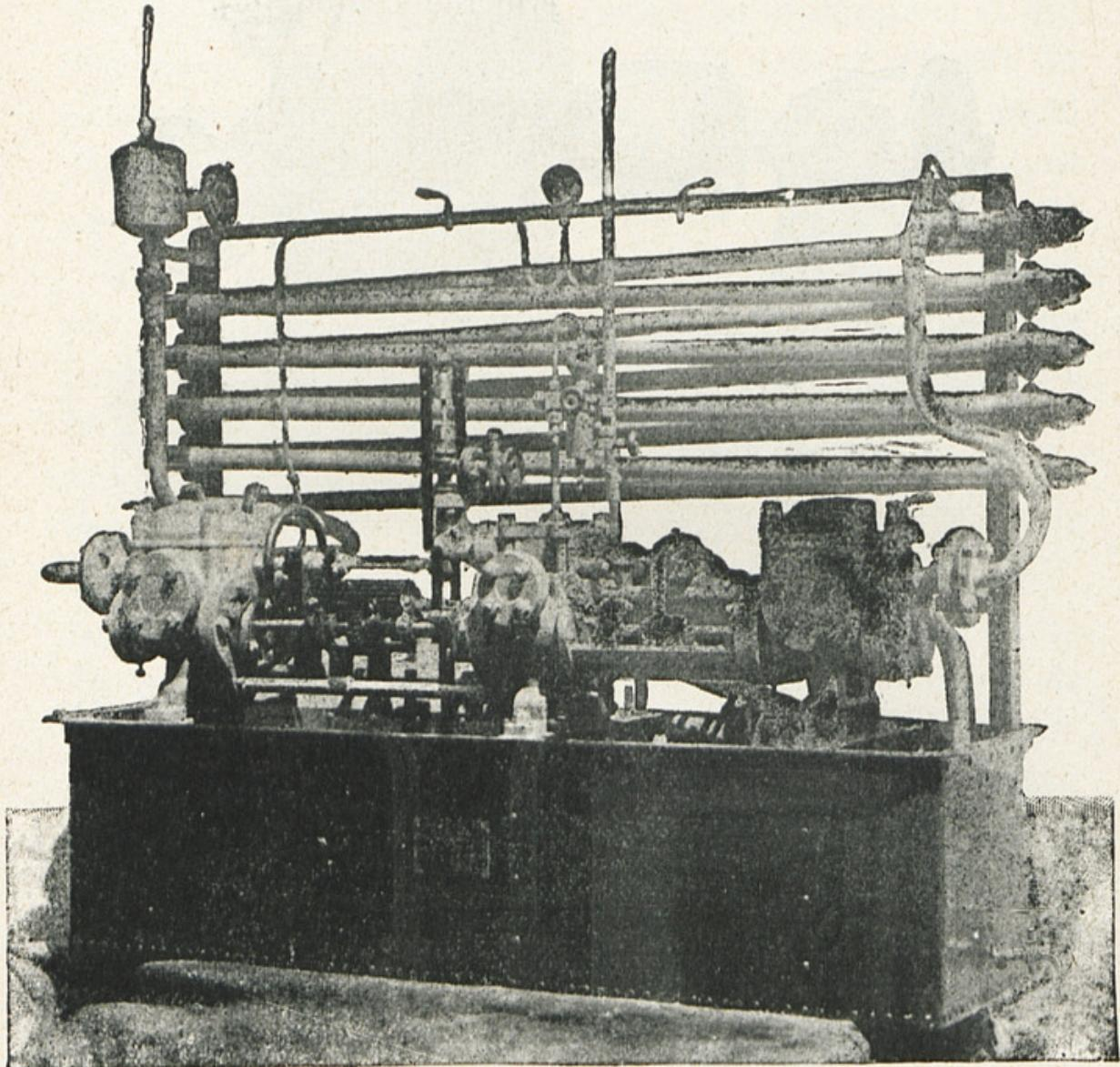
FIG. 66. — Réfrigérant automatique (système Egrot).
