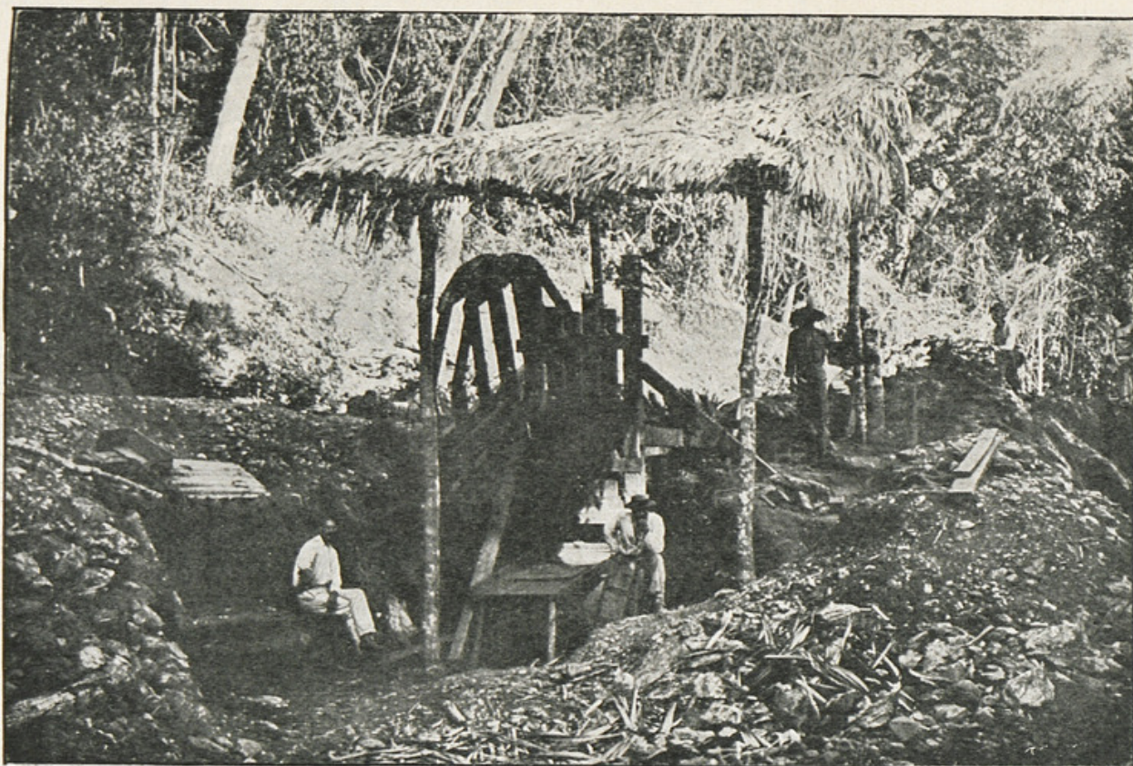
Moulin de fortune, ou premier Moulin du Callao, analogue à celui que dut employer don Antonio à ses débuts. [(Photographie du Petit Moulin que monta, en 1900, sur le filon de Saint-Louis (Caroni) M. l'Ingénieur H... avec des matériaux provenant de ma drague.)]
