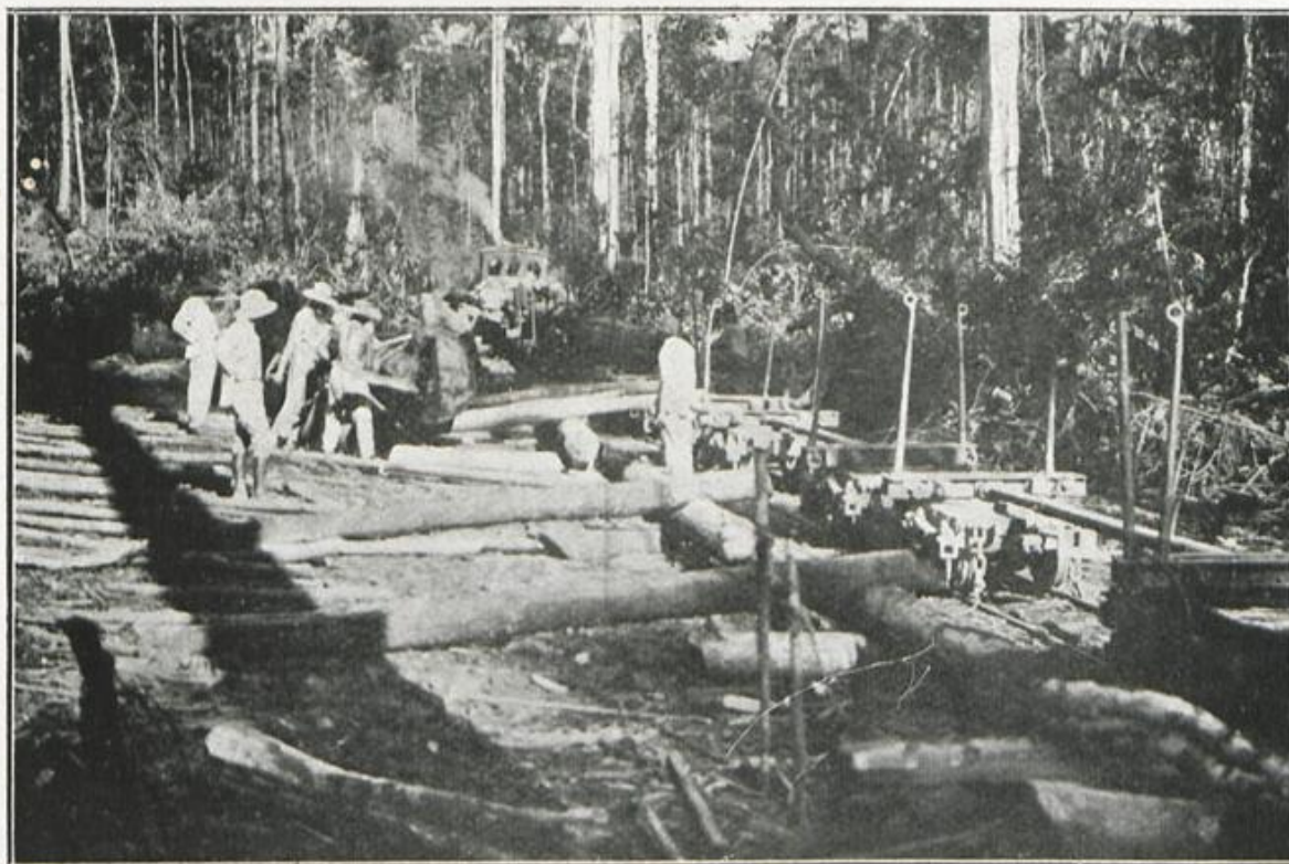
Chargement de grumes sur boggies, dans un chantier d'exploitation de la S. F. G. F., pour le transport par voie ferrée, dans ses chantiers de Saint-Laurent-du-Maroni.
