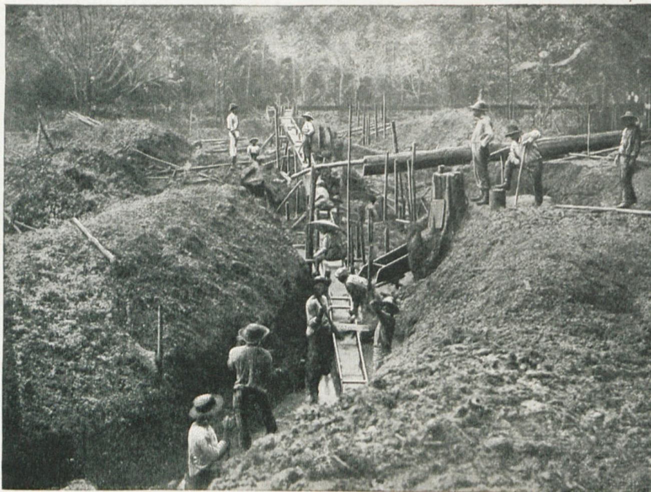
UN SLUICE EN FONCTION.
