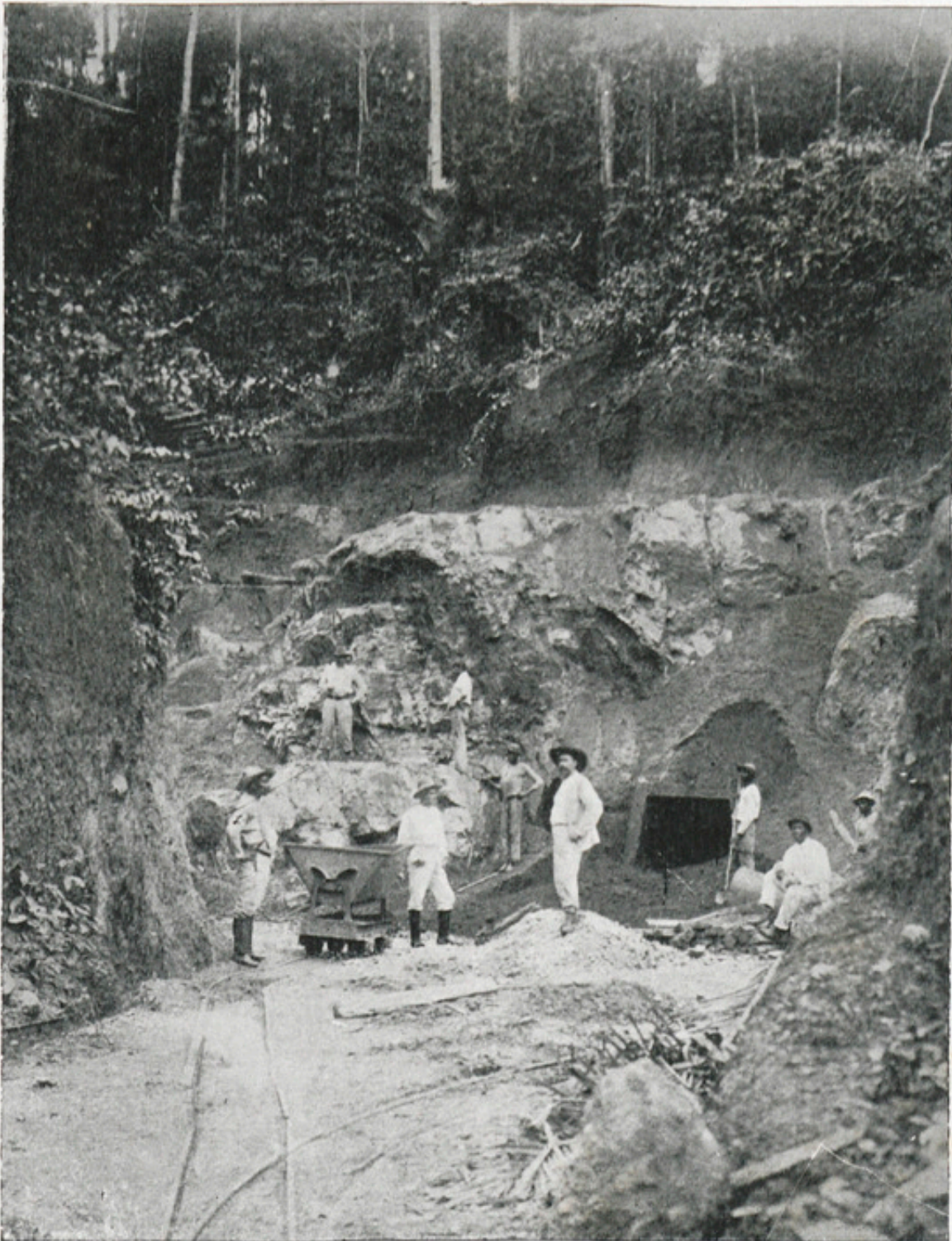
ENTRÉE D'UNE EXPLOITATION FILONNIENNE
